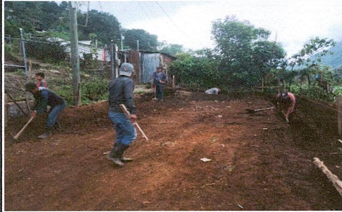
Foto 1: planando el terreno para la cocina, baños y lavamanos
