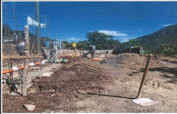
Foto 3: fundición de las partes de la cocina, lavamanos y baños
