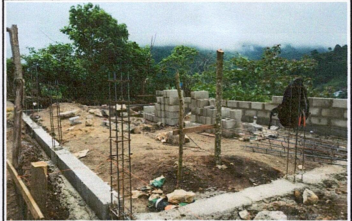
Foto 4: levantado de block de los tres bloque propuestos
